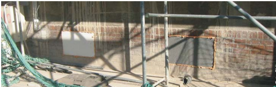
Abbildung 59 Mit Dämmblöcken verschlossene Kellerfenster - die ganze Außenwand wurde nachfolgend bis knapp über OK-Erdreich wärmegeklämt. (Quelle: PHI, [203])
