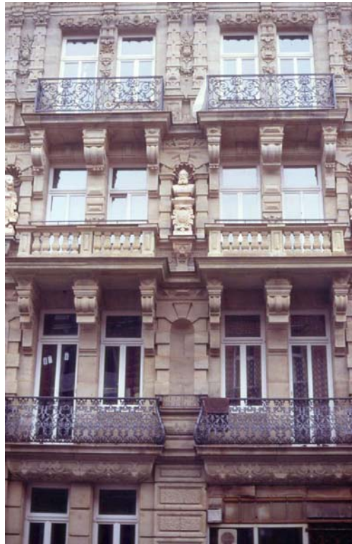
Abbildung 28 Auch bei solchen Stadthäusern mit einer reich strukturierten Straßenfassade, die nur innen gedämmt werden kann, lässt sich häufig auf der schlichteren, straßenabgewandten Fassade eine Außendämmung verwirklichen. (Quelle: Schulze Darup)
