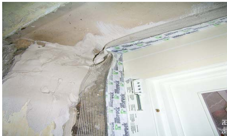
Abbildung 106 Fensteranschluss mit Dichtungsbändern an die auf der Außenseite Außenwand liegende Luftdichtheitsebene. Die Luftdichtheit in der Fläche wird in diesem Fall durch eine vollflächige Spachtelung auf dem bestehenden Außenputz hergestellt (im Bild noch nicht ausgeführt). Danach wird das Wärmedämm-Verbundsystem angebracht. (Quelle: PHI, [202])
