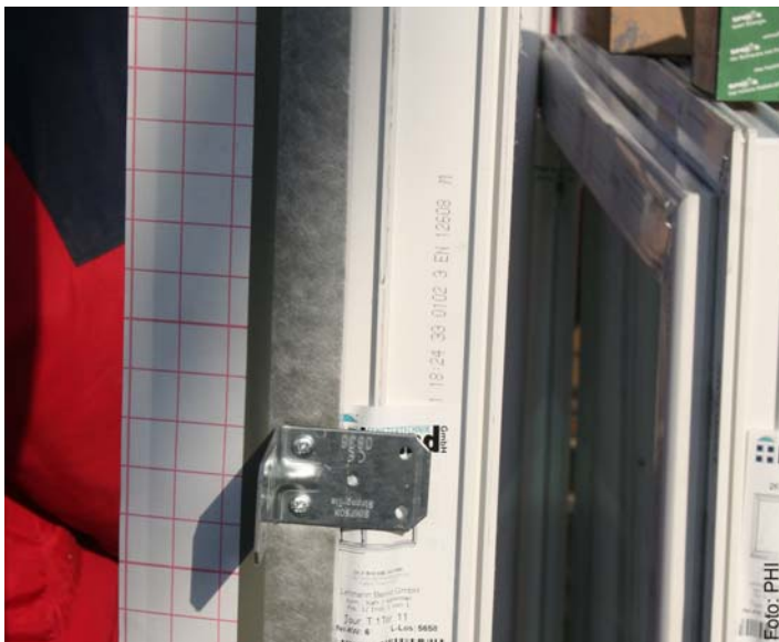
Abbildung 101 Vor der Montage werden zuerst die Dichtungsbänder und dann die Befestigungswinkel am Fensterrahmen angebracht. (Quelle: PHI)
