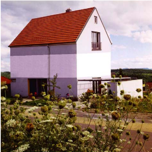
Abbildung 14 Das Erdgeschoss ist bezüglich der Wärmeverluste fast „doppelt so hoch“, wenn ein Sockelprofil aus Aluminiumblech verwendet wird (Fotomontage: ebök)
