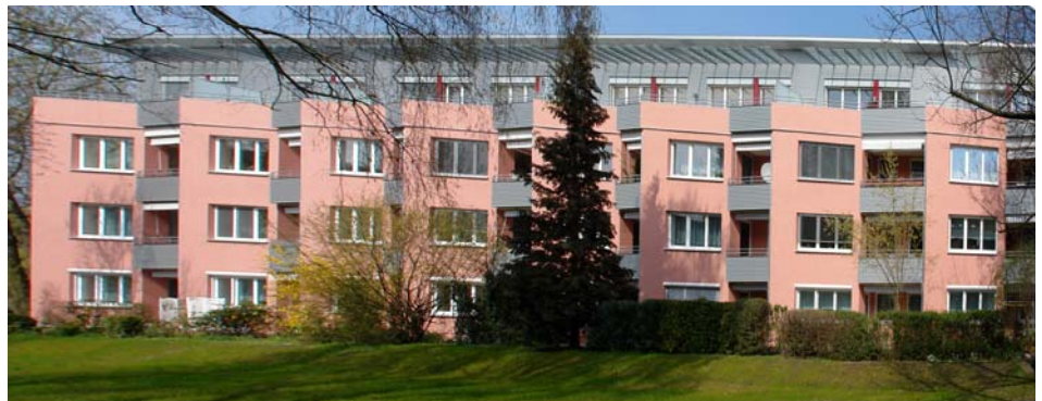
Abbildung 9 Mit Wärmedämm-Verbundsystem modernisiertes, denkmalgeschütztes Gebäude (Quelle: Architekt Schulze Darup, Sanierungsprojekt Bernadottestr. 42-48, WBG Nürnberg,)
