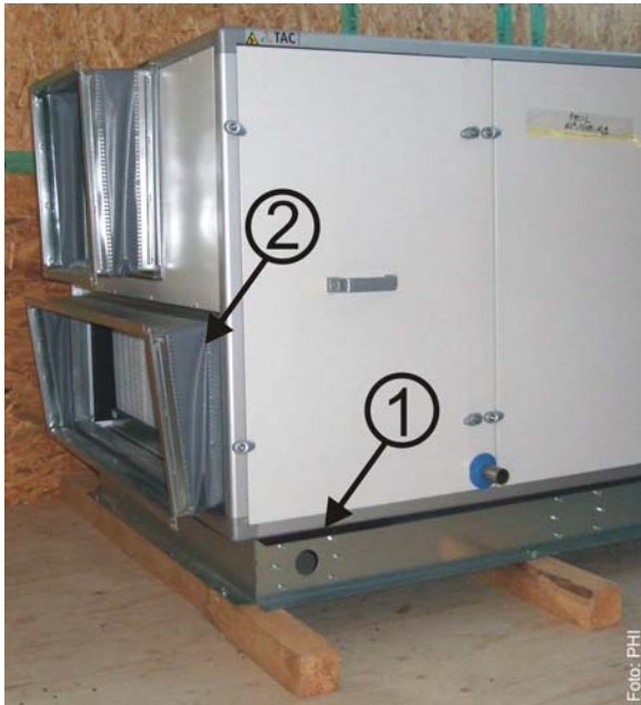
Abbildung 165 Körperschallentkopplung an einem zentralen Lüftungsgerät (Lüftungskanäle sind noch nicht installiert):
