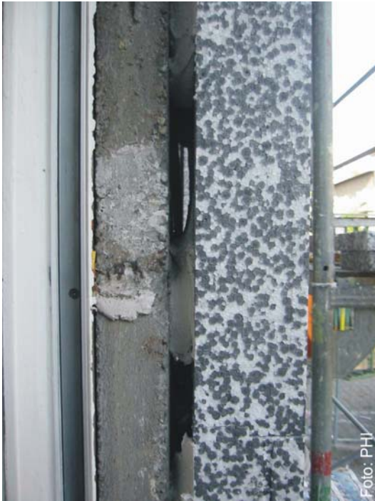
Abbildung 10 „Freischwebende“ nur mit wenigen Kleberbatzen befestigte Dämmplatte. Die Dämmwirkung ist hier durch Hinterströmung mit Außenluft zumindest stark vermindert. Zudem können durch eine ungenügende Fixierung der Dämmplatte Risse im Putz entstehen. (Quelle: PHI)
