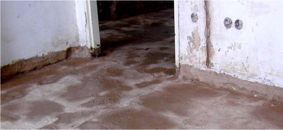
Abbildung 24 Im Altbaubestand ist der Innenputz häufig schadhaft und wurde nicht vollständig an den Rohfußboden angeschlossen. Wird der Fußbodenaufbau wie auf diesem Foto ohnehin erneuert, sollte die Gelegenheit zur entsprechenden Ergänzung des Innenputzes genutzt werden. (Quelle: faktor10 Darmstadt)
