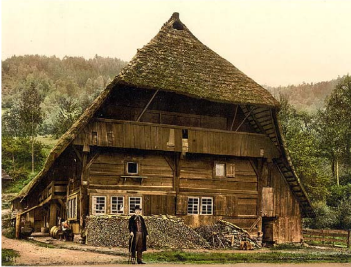
Abbildung 157 Schwarzwälder Bauernhaus um 1900. Die Holzkonstruktion wurde durch weit auskragende Dachüberstände vor Schlagregen geschützt. [25]
