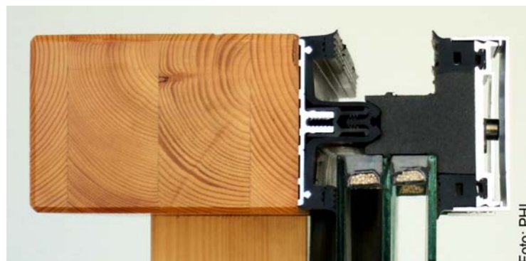
Abbildung 97 Gedämmte Fensterrahmen mit Dreifach-Verglasung im Querschnitt. Erkennbar ist die vergrößerte Bautiefe, sowie der erhöhte Glaseinstand der den thermisch getrennten Randverbund überdeckt. Von links nach rechts: Holz-PUR mit gedämmter Alu-Vorsatzschale, Holz-Kork, Holz-PUR, PVC mit gedämmter Alu-Vorsatzschale und thermisch getrenntem Aussteifungsprofil, PVC mit gedämmten Kammern (Quelle: PHI).
