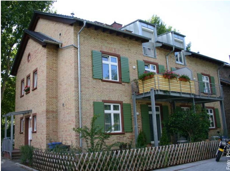
Abbildung 27 Altbau nach der energetischen Modernisierung. Wegen der erhaltenswerten Sichtmauerwerksfassade entschied sich der Bauherr für eine Innendämmung (Quelle: PHI, [205])
