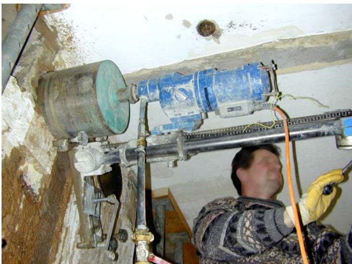
Abbildung 135 Kernbohrung für die Durchführung des Außenluft- und Fortluftkanals durch die Außenwand (Quelle: faktor10 Darmstadt)
