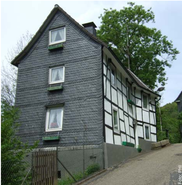
Abbildung 42 In Gebieten mit hoher Schlagregenbelastung (hier: Bergisches Land) wird zum Schutz der Fachwerkkonstruktion traditionell zumindest die Fassade auf der Wetterseite mit einer Bekleidung versehen. (Quelle: PHI)
