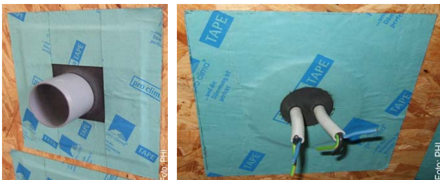
Abbildung 88 Manschetten für Kabel- und Rohrdurchführungen; alternativ ist auch eine „handwerkliche“ Ausführung der Abdichtung möglich. (Quelle: PHI[58])
