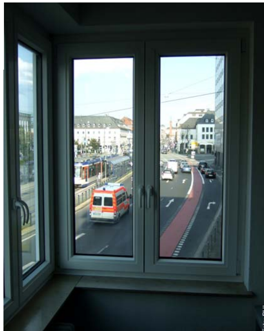
Abbildung 164 Mit passivhaustauglicher Schallschutzverglasung (Dreifach-Wärmeschutzverglasung mit 1xVSG) und einem luftdichten Fenstereinbau konnte in dieser stark durch Verkehrslärm belasteten Altbausituation eine neue Aufenthaltsqualität im Innenraum erreicht werden. (Quelle: PHI)
