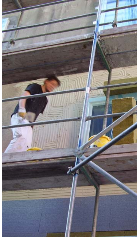
Abbildung 11 Vollflächiges Aufbringen des Klebers für das Wärmedämm-Verbundsystem mit einem Zahnpachtel zur gleichzeitigen Herstellung einer luftdichten Ebene auf der Außenseite der Bestandswand (Quelle: faktor10 Darmstadt)
