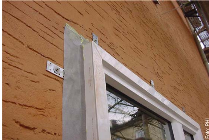
Abbildung 106 Fensteranschluss mit Dichtungsbändern an die auf der Außenseite Außenwand liegende Luftdichtheitsebene. Die Luftdichtheit in der Fläche wird in diesem Fall durch eine vollflächige Spachtelung auf dem bestehenden Außenputz hergestellt (im Bild noch nicht ausgeführt). Danach wird das Wärmedämm-Verbundsystem angebracht. (Quelle: PHI, [202])
