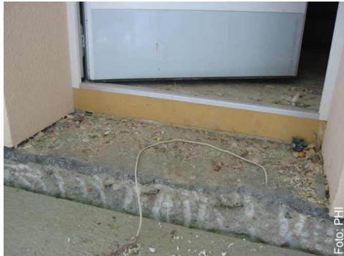
Abbildung 108 Einbau einer wärmegeämmten Haustür im Zuge der energetischen Modernisierung eines Mehrfamilienhauses. Der Türrahmen wird seitlich und oben mit dem Wärmedämm-Verbundsystem überdämmt. Die Anschlagschwelle liegt auf einem Block aus druckbelastbarem aber trotzdem wärmedämmendem PU-Recyclingmaterial (hellbraun). (Quelle: PHI, [203])
