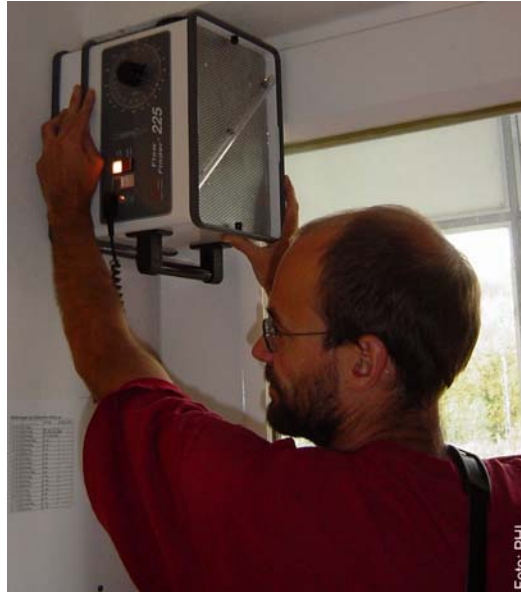
Abbildung 121 Messung des Volumenstroms an einem Zuluftventil (Quelle: PHI)
