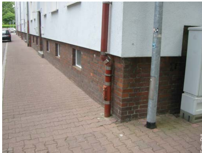
Abbildung 60 Konventionelle Sanierung: Unzureichende Wärmedämmung der Außenwand nur bis UK-Kellerdecke (Quelle: PHI)
