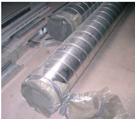
Abbildung 123 Das Innere von Lüftungskanälen muss während der Lagerung auf der Baustelle immer vor Verschmutzungen geschützt sein. (Quelle: Architekt Schulze Darup, Sanierungsprojekt Ingolstädterstr., WBG Nürnberg)
