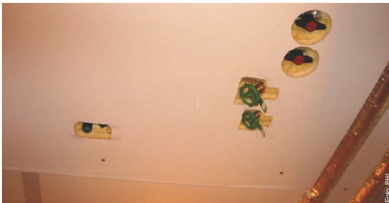
Abbildung 56 Kellerdeckendämmung mit halb und ganz integrierten gedämmten Warmwasserleitungen und Aussparungen für die Absperrventile (Quelle: PHI, [203])
