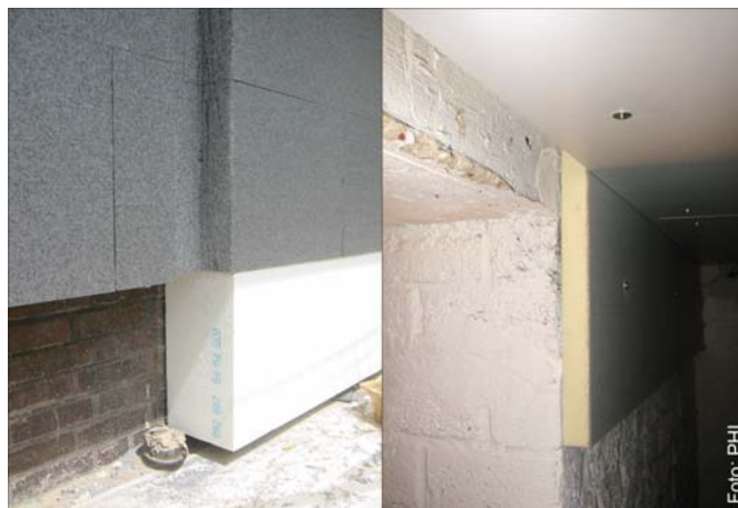
Abbildung 60 Konventionelle Sanierung: Unzureichende Wärmedämmung der Außenwand nur bis UK-Kellerdecke (Quelle: PHI)
