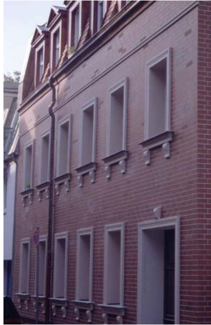
Abbildung 16 Nachbildung einer historischen Backstein-Fassade mit sogenannten „Riemchen“ auf einem Wärmedämm-Verbundsystem (Quelle: Schulze Darup)
