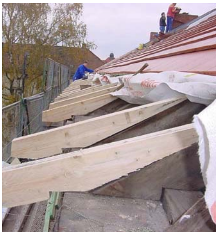
Abbildung 170 Montage eines „Aufschieblings“ als Zusatzmaßnahme für die Herstellung einer durchgehenden Wärmedämmung (Quelle: Architekt Schulze Darup, Sanierungsprojekt Jean-Paul-Platz, WBG Nürnberg)
