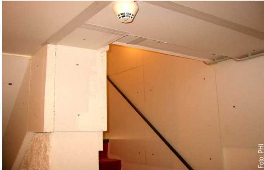
Abbildung 66 Deckendämmung und Begleitdämmung der Wände bei der Kellertreppe eines Geschosswohnungsbaus nach der Sanierung (Quelle: PHI, [203])
