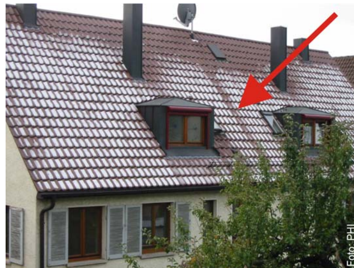
Abbildung 80 Wärmebrücken durch bis Oberkante Sparren reichende Giebel- oder Haustrennwände (links) können durch eine durchlaufende Aufsparrendämmung (rechts) wirksam entschärft werden. Wird die Giebelwand nicht gleichzeitig gedämmt, so muss eine Lösung für den Wandputz-Streifen am Ortgang an der Stirnseite der Aufsparrendämmung gefunden werden (rechts). (Quelle: PHI, [218])
