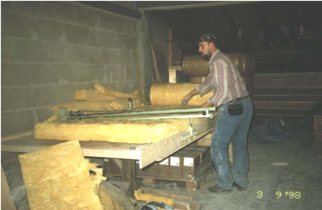
Abbildung 52: Die Dämmmatten werden zentimetergenau maßgeschneidert
