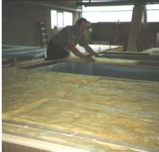
Abbildung 54: Der Dämmstoff muß locker und leicht überhöht im Element liegen, damit sich später keine Hohlräume bilden
