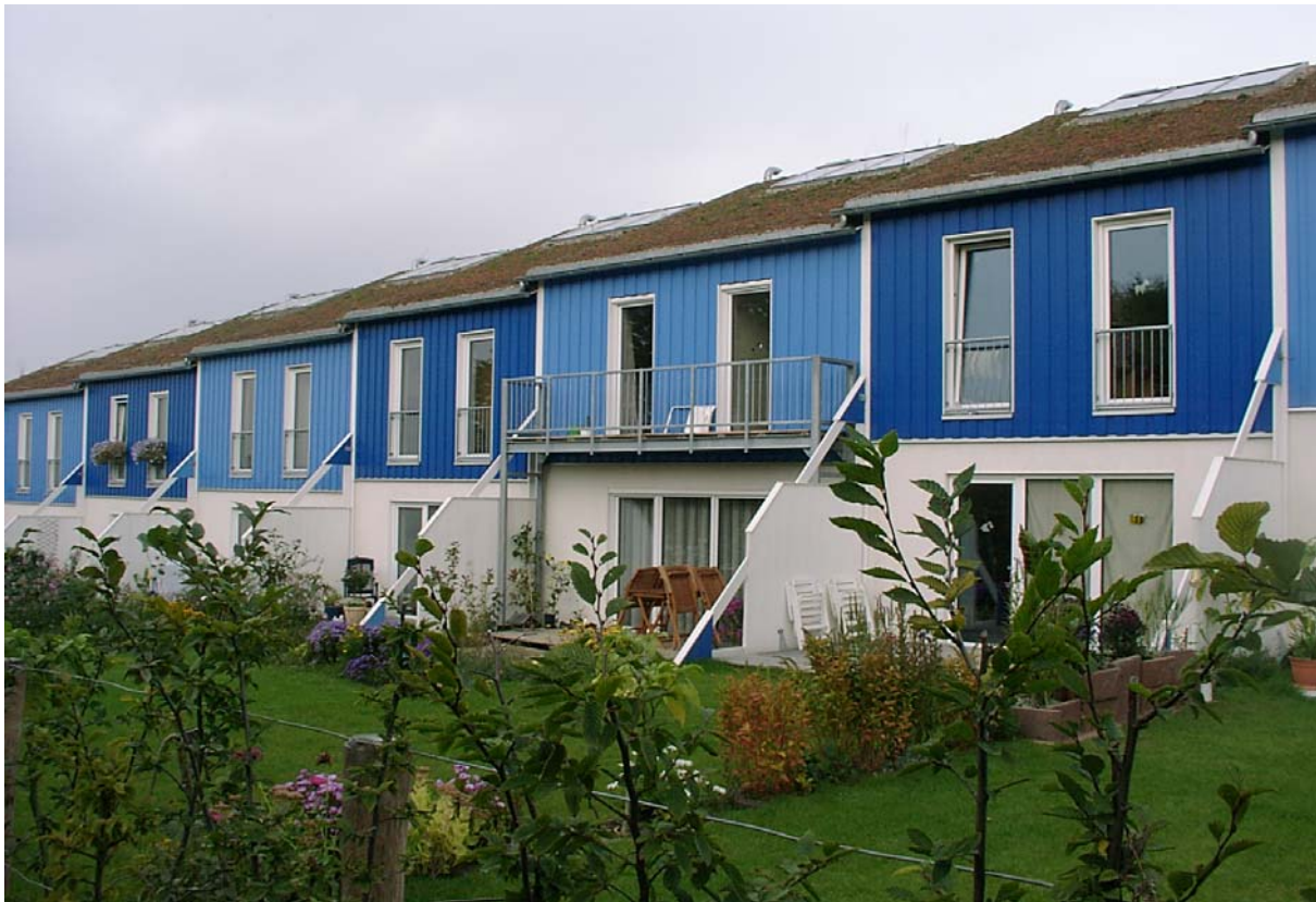
Abbildung 4: Ansichten der Südfassaden der Passivhauszeilen in Hannover-Kronsberg
