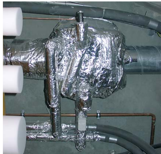
Abbildung 36: Heizregister in der Zuluftleitung (vor und nach der Montage der Wärmedämmung)
