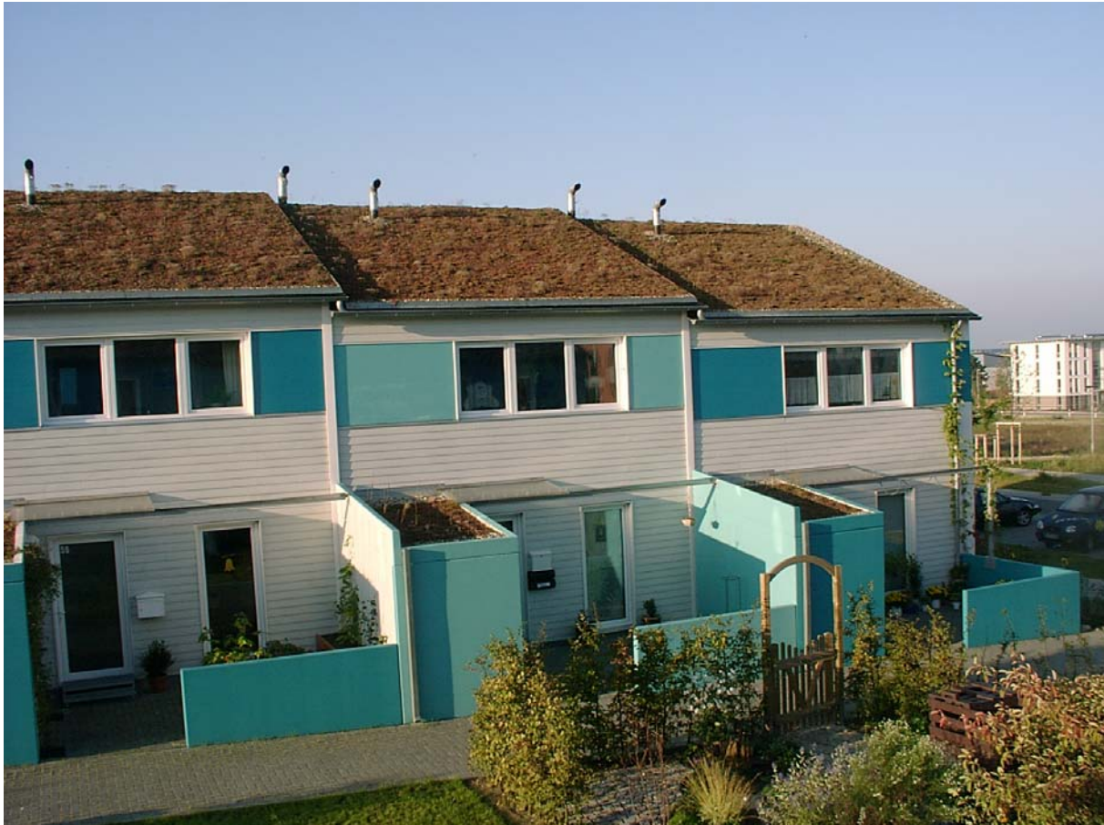
Abbildung 5: Ansichten der Passivhauszeilen in Hannover-Kronsberg von der Nordseite
