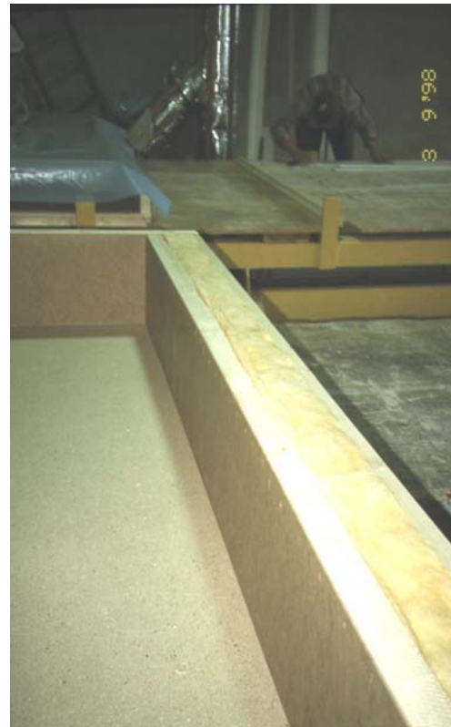
Abbildung 53a/b: Die Dämmung wird paßgenau in die Holzbauelemente eingebracht
