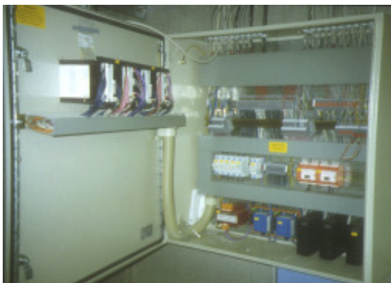
Abb. 5 und Abb. 6: Links: Schaltschrank im Technikhaus 9/10 mit zwei DDC-Zentralen. Rechts: GLT-Zentralrechner zur Datenerfassung und DOS-PC mit Modems sowie Standleitungstreibern im Abstellraum EG von Haus 9.8
