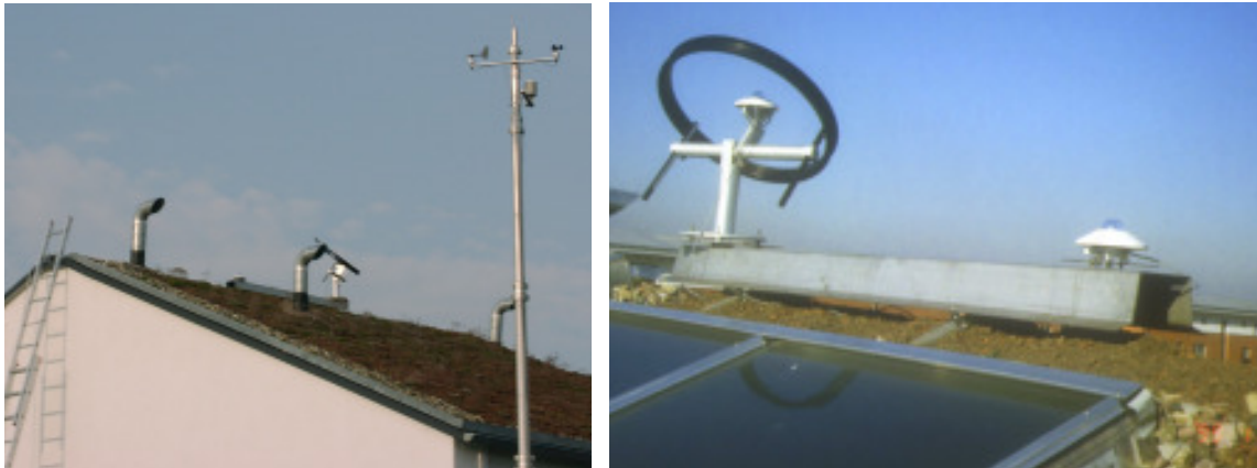
Abb. 22 und Abb. 23: Wetterstation in der Passivhaussiedlung. Links: Teleskopmast mit den Sensoren (Am Giebel angelehnt die Leiter zur Schattenringnachstellung). Rechts: Strahlungsmessgeräte mit und ohne Schattenring auf dem First von Haus 9/8 (Im Vordergrund ein Teil des Kollektorfeldes der Solaranlage).
