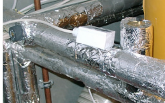
Abb. 16 und Abb. 17: Kalt- und Warmwassertemperaturmessung im Technikgeschoß (Anlegefühler). Beim Warmwassersensor (rechtes Bild) ist am linken Bildrand der Einstelldrehkopf des Brauchwassermischers zu erkennen. Im rechten Bildteil sieht man den Brauchwarmwasserspeicher.
