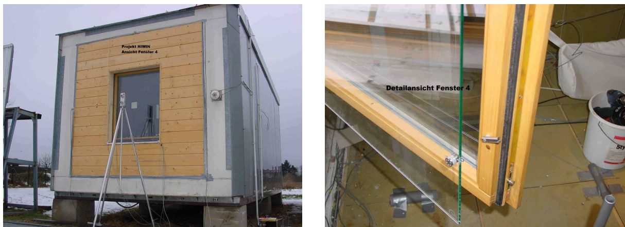
Bild 20 Verbundfenster Visiostar (Einbausituation und Detail, Foto BTU Cottbus)
