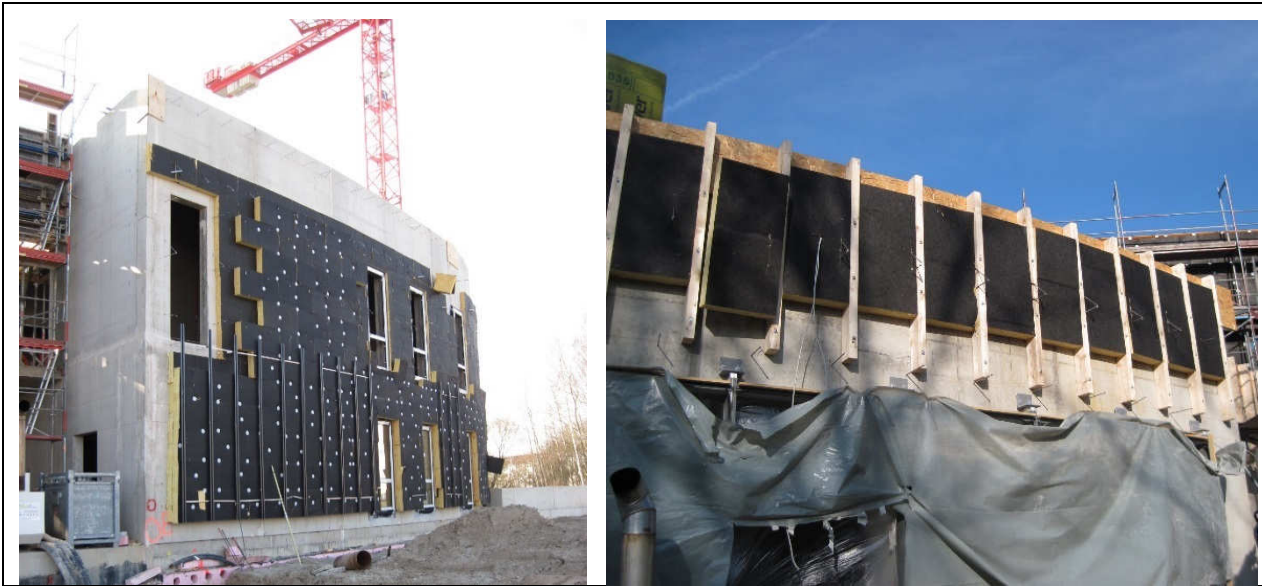
Abbildung 7: Wanddämmung, filigrane Fassadenanker und Attikakonstruktion aus Holz
