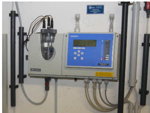
Abbildung 10: Chemische Messzelle zur Überwachung des Beckenwassers
