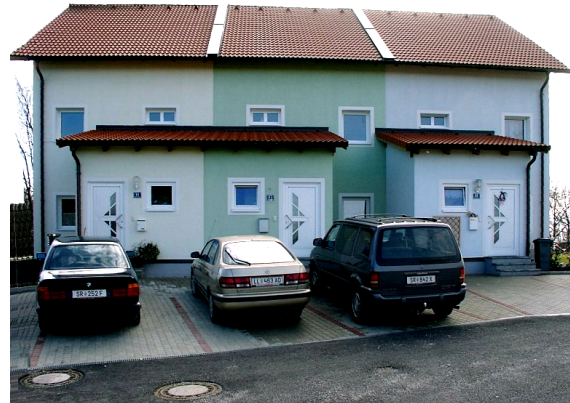
Ansicht Nord (Fotos: Pfluger)
