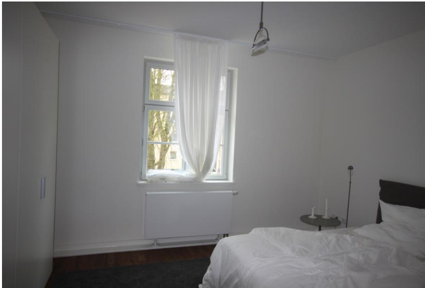
Abbildung 21: 1.OG Wohnung rechts/ erstes Zimmer straßenseitig, Dämmsystem: PS-Hartschaumplatte
