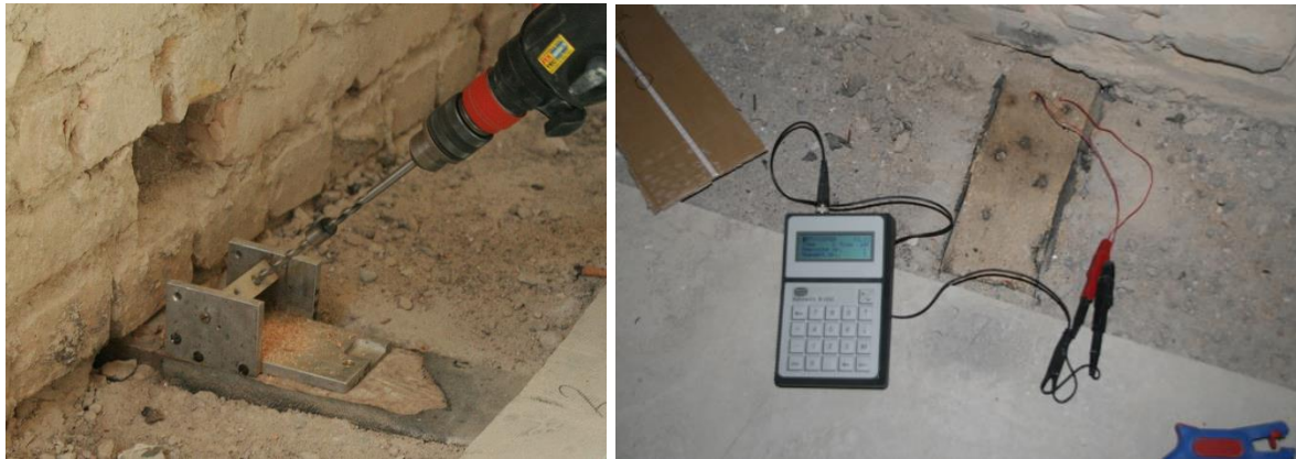
Abbildung 29: Bohrvorrichtung für die Holzfeuchtesensoren (links) und installierte Sensorik (rechts) für die hochohmige Widerstandsmessung (Testaufbau).
