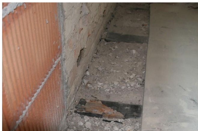
Abbildung 13: Innenansicht der Außenwand mit abgetragenem Innenputz sowie freigelegten Holzbalkenenden
