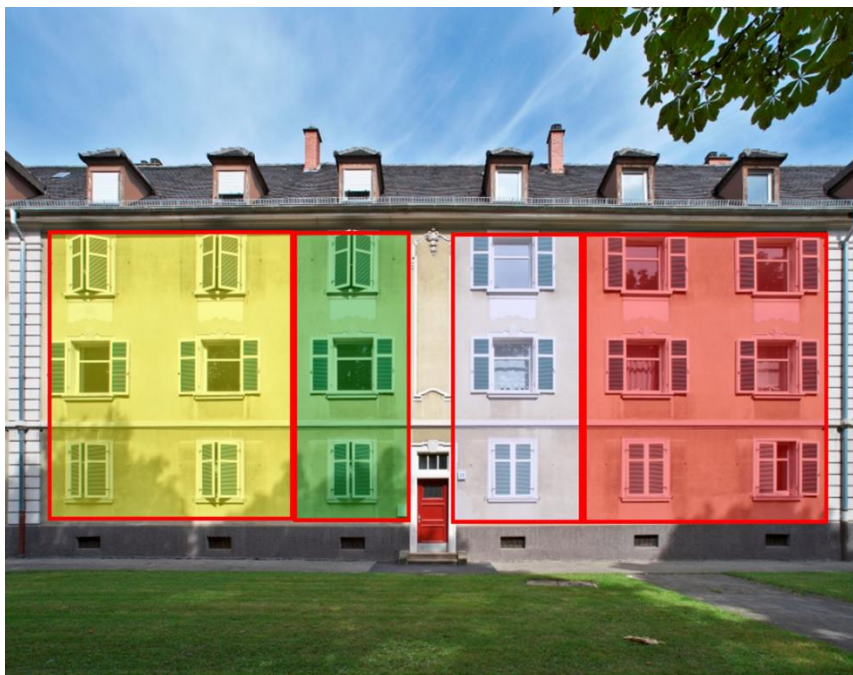
Abbildung 7: Fassadenansicht mit den vier unterschiedlich farbig gekennzeichneten Innendämmvarianten von links: Heck-Dämmputz, IQ-Therm-Dämmplatte, Polystyrol-Hartschaumplatte, Heck-Dämmplatte
