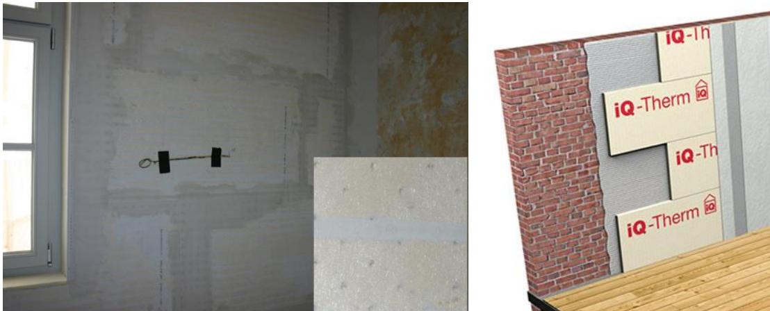
Abbildung 9: IQ-Therm-Dämmplatte nach Anbringung (links), schematische Darstellung (rechts) Quelle: Remmers
