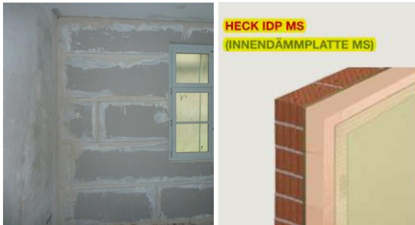
Abbildung 11: Heck-Innendämmplatte nach Anbringung (links), schematische Darstellung (rechts) Quelle: BASF
