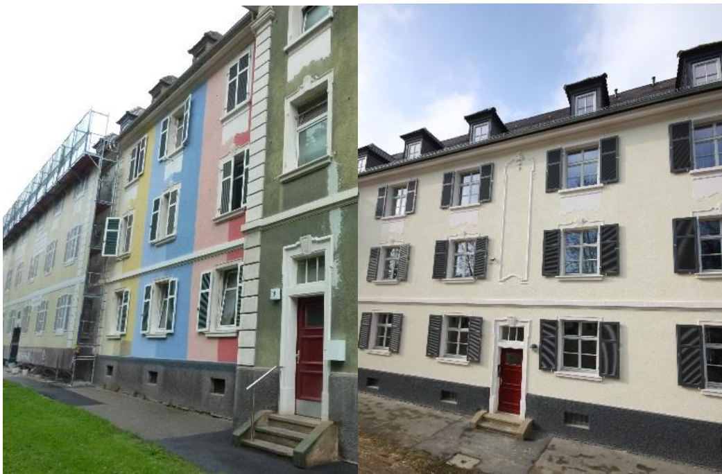
Abbildung 1: Straßenseitige Außenansicht der Hohenzollern-Höfe zu Beginn der Sanierungsarbeiten (links) und nach Fertigstellung der Baumaßnahmen (rechts).
