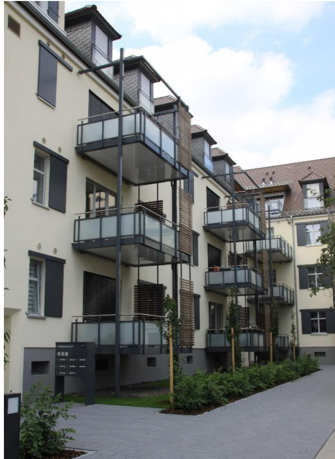
Abbildung 2: Außenansicht von der Innenhofseite, über die der Hauptzugang zu den Wohnungen erfolgt. Hier konnte ein außenseitiges Wärmedämmverbundsystem angebracht und Balkone vorgesetzt werden.
